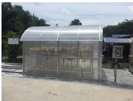
ภาพที่ 2.6 ระบบการอบแห้งแบบ Active
